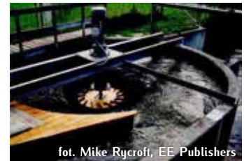
Turbiny wirowe vortex.
