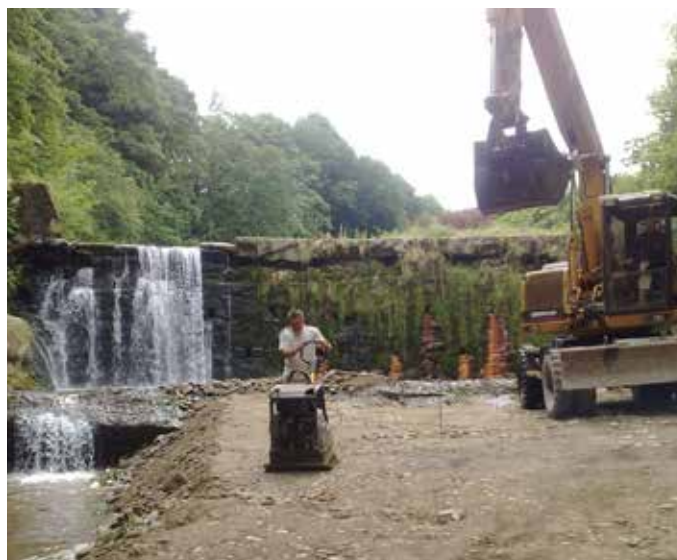
Fot. Zapora na potoku Trzebuńka przed przebudową – rok 2015 (J. Jeleński).
