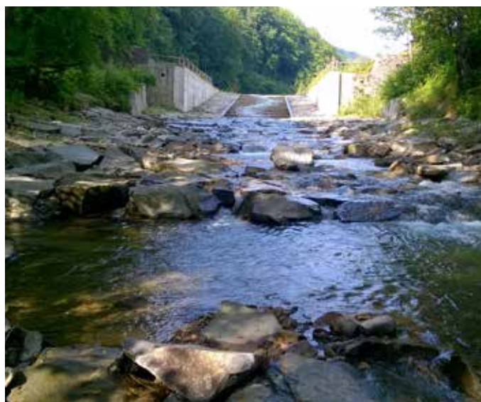
Fot. Zapora na potoku Trzebuńka po przebudowie – rok 2018 (J. Jeleński).
