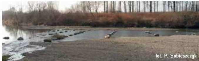
Ażurowe ułożenie głazów w korycie Wistoki.
