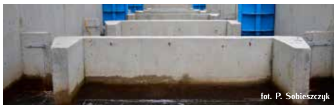
Przepławka dwuszczelinowa przy stopniu w km 108+080 Wistoki w miejscowości Jasto.
