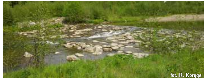
Bystrze o zwiększonej szorstkości na pot. Porębianka.
