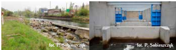
Bystrotok przy stopniu w km 107+200 Wisłoki w miejscowości Jasto (po lewej).
