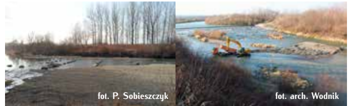
Ażurowe ułożenie głazów w korycie Wisłoki (po lewej).
