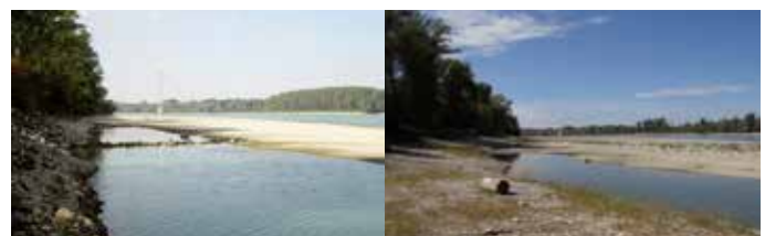
Usunięcie umocnień brzegowych na Dunaju.
