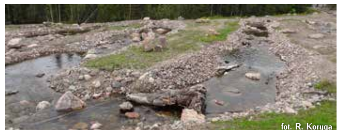
Kanał tartkowy przy elektrowni Imatrankoski na rzece Vuoksi w Finlandii.
