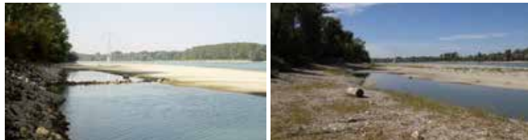
Usunięcie umocnień brzegowych na Dunaju (fot. Österreichische Wasserstraßen- Gesellschaft mbH).
